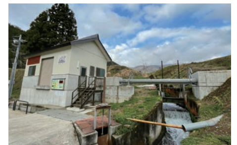
写真上：スキー場内レストランに設置されているウォーターサーバー。「水と人が循環する村」というコンセプトも掲示されている。写真下：村内を流れるまくなえ川を活用した「まくなえ川小水力発電所」。年間発電量は約600MWhで一般的な家庭が使う電力120世帯分に相当する。売電による収益は発電施設の維持管理の他、下水道終末処理場の電気代に活用。
